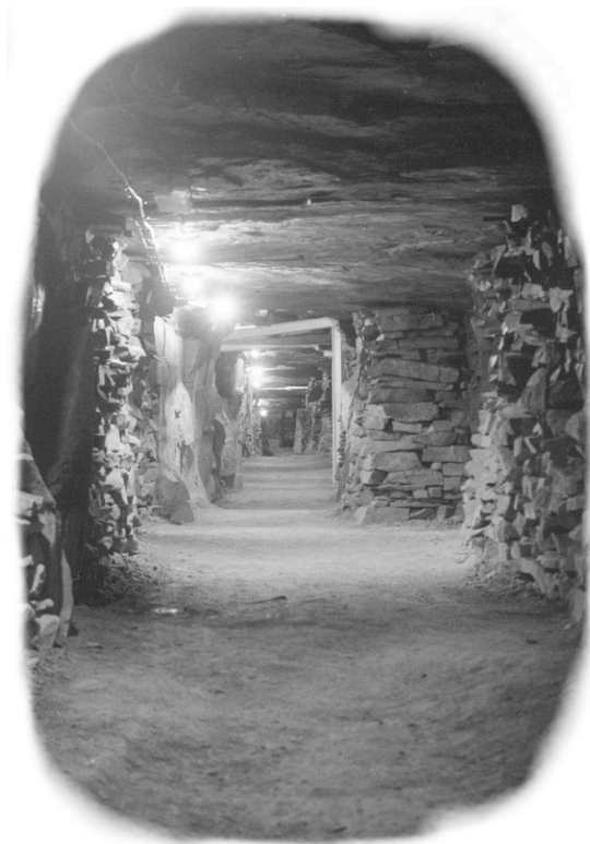
Foto 3: inblik in de ondergrondse gangen van de Petit Banc-groeve
